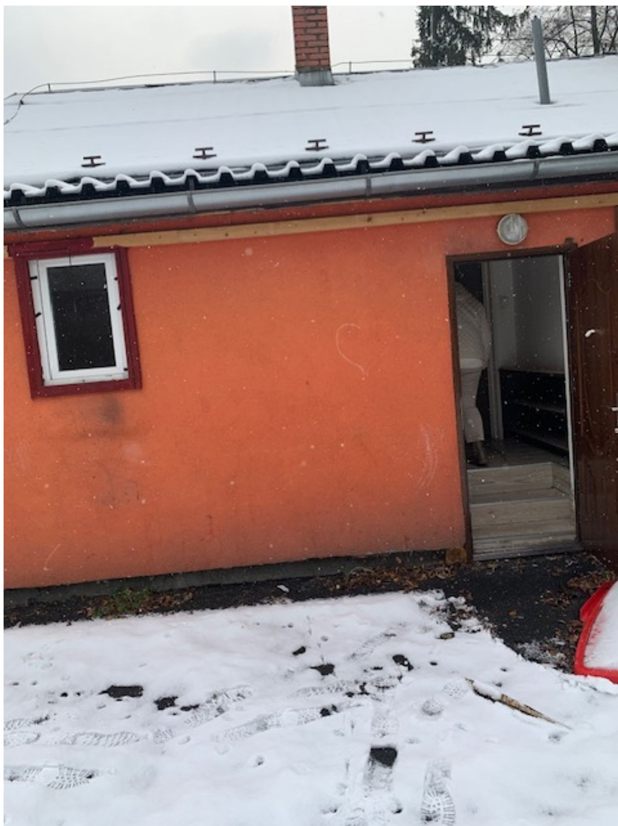
Vnější pohled na vstup.
