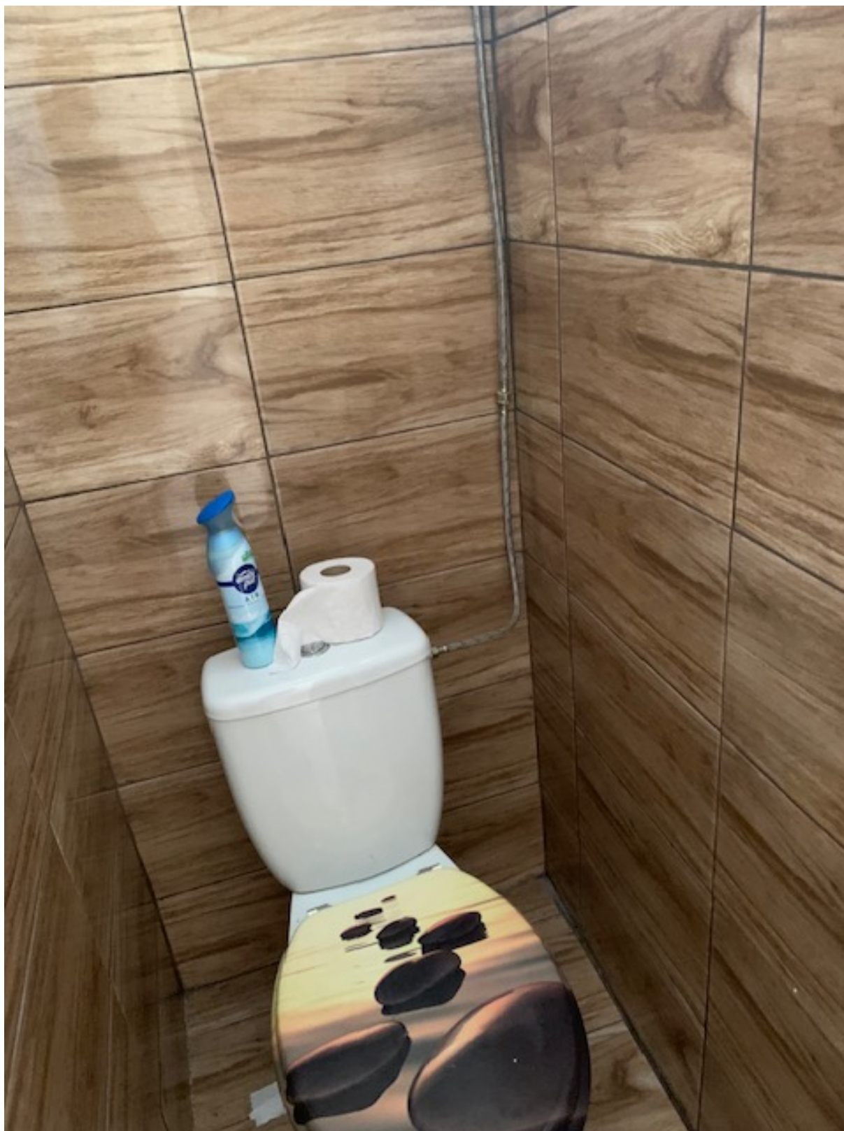
WC se záchodovou mísou a obnažené napojení
