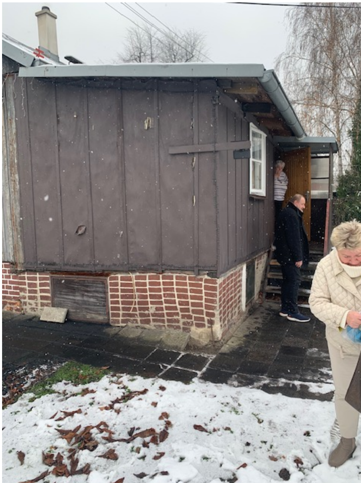
Vnější pohled na přístavbu
