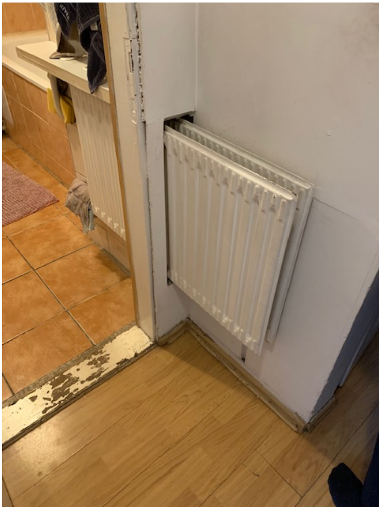
Přechod koupelna vs chodba
