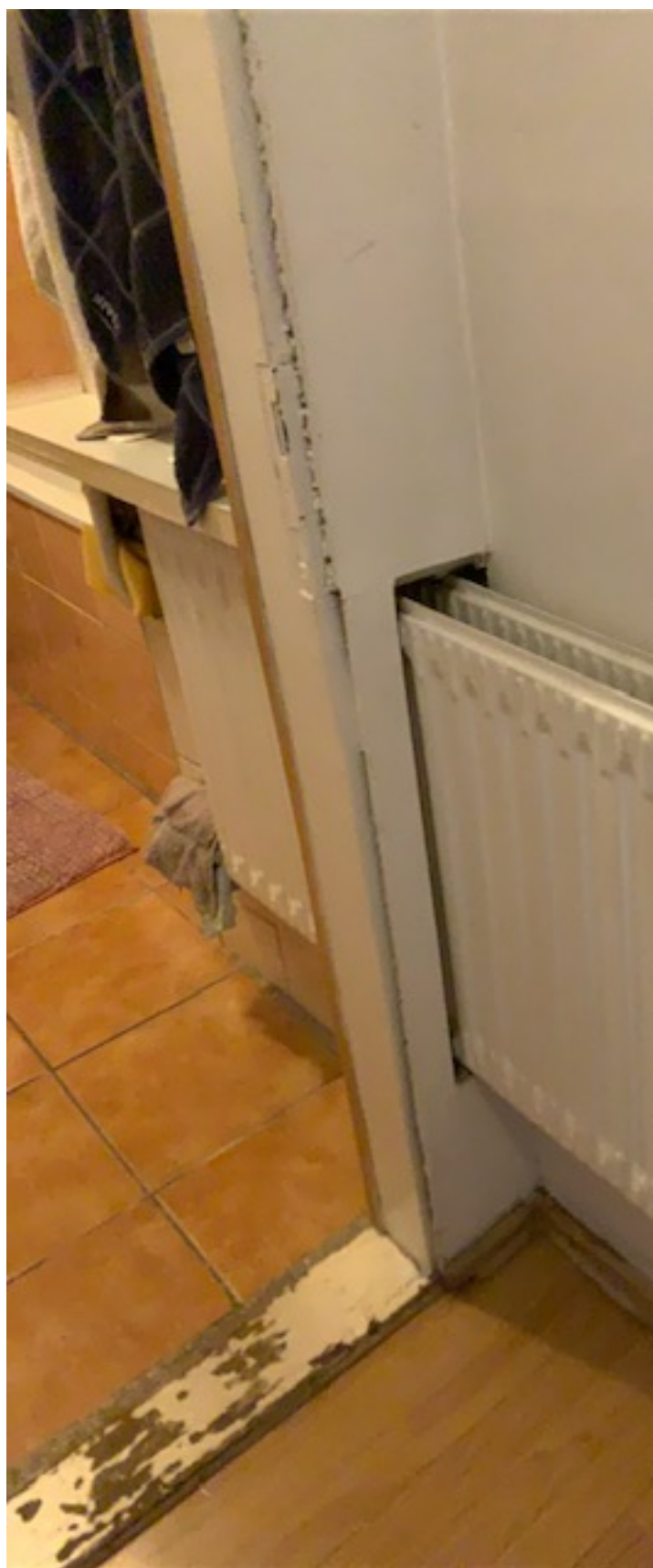
Nestandardní umístění radiátoru topení
