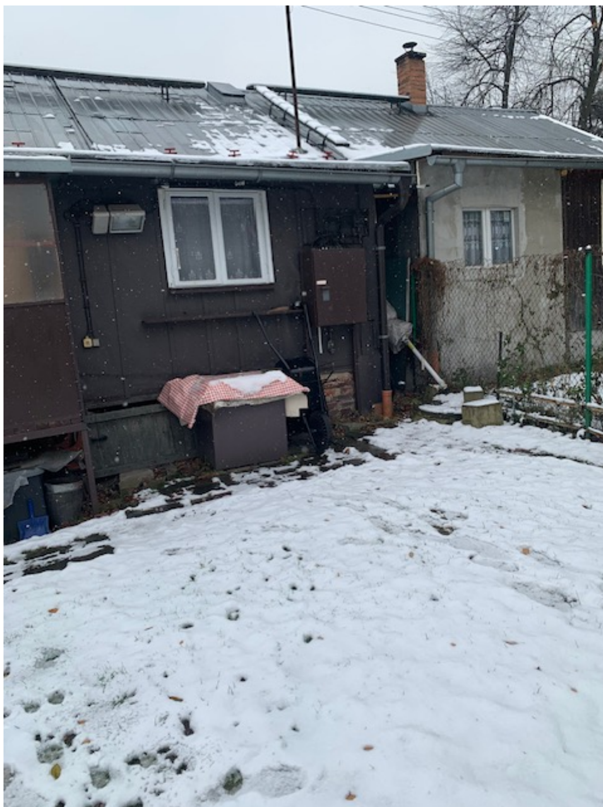
Pohled vnější ,okno do kuchyně
