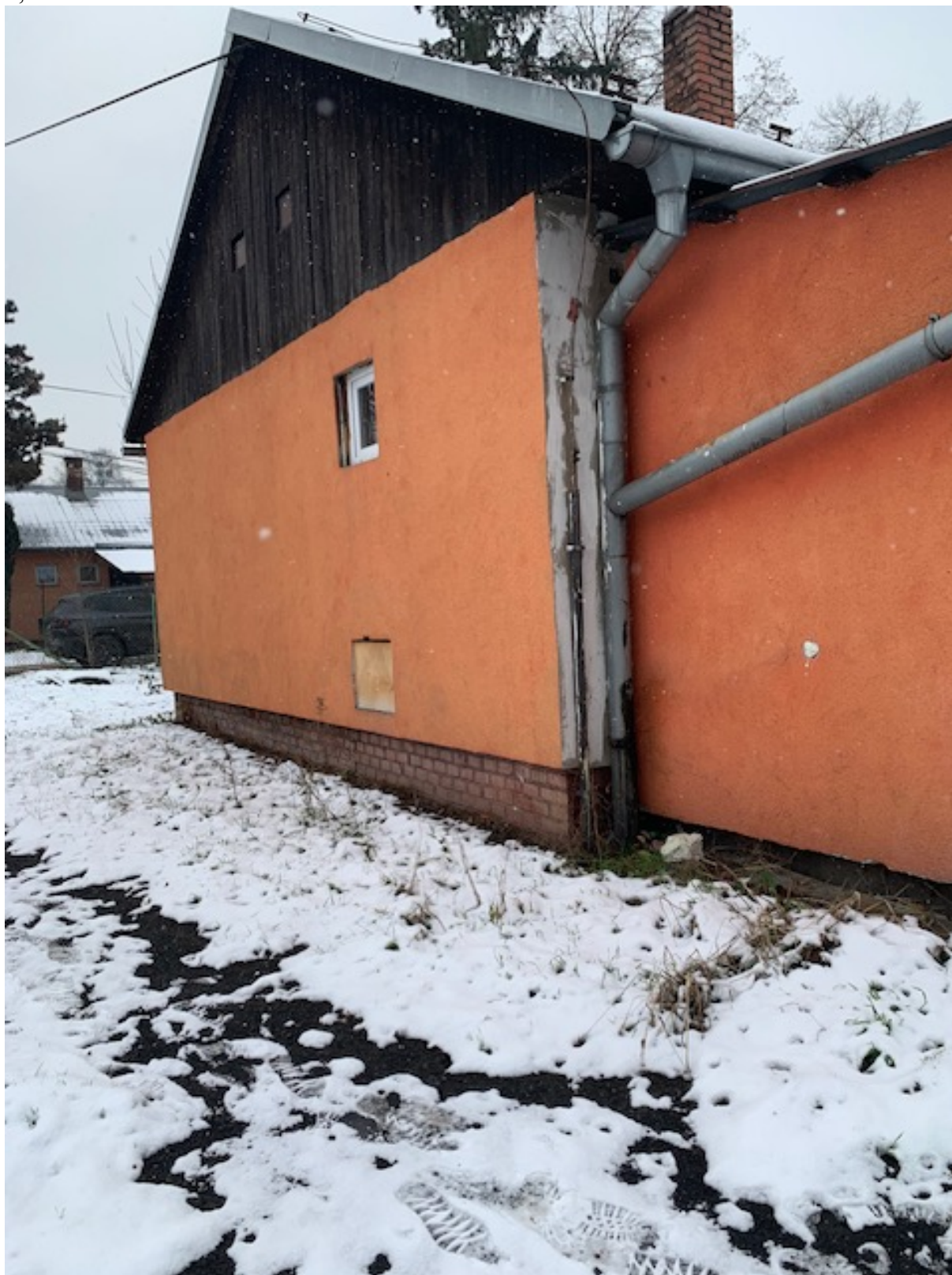
Boční pohled s přístavbou – napojení odvodu dešťové vody
